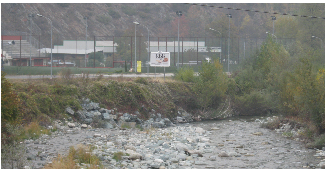
Figura 8 – Difesa spondale in sinistra idrografica da consolidare e priva dell'immorsamento spondale nel tratto di monte
