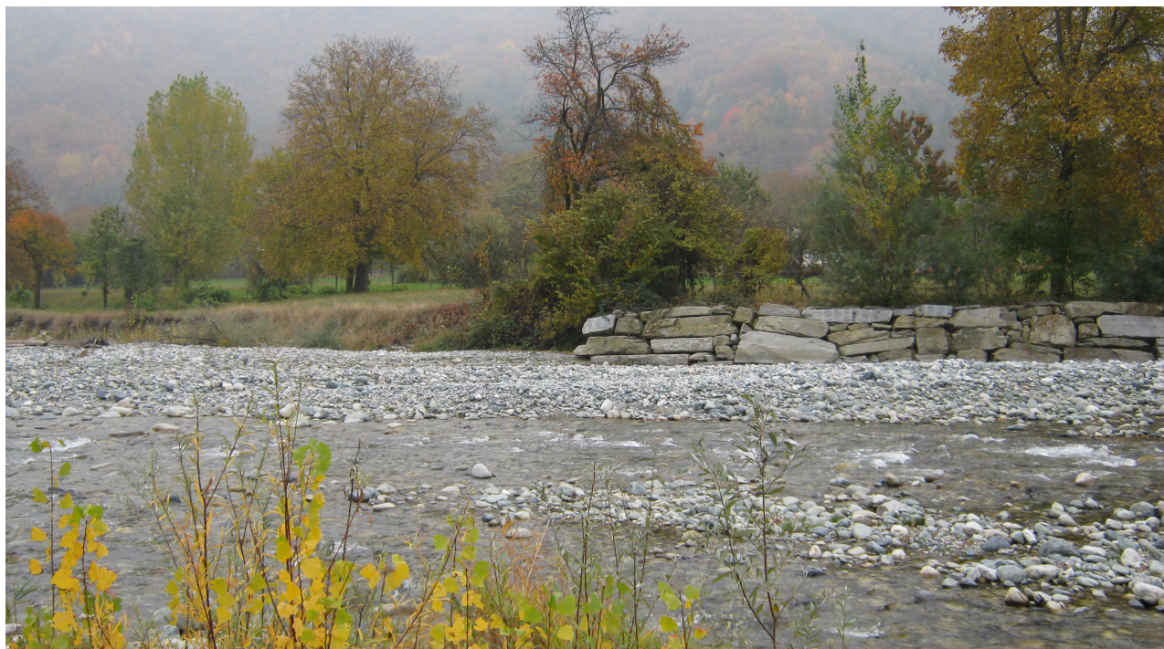
Figura 9 – Difesa spondale in destra idrografica priva dell’immorsamento spondale di valle
