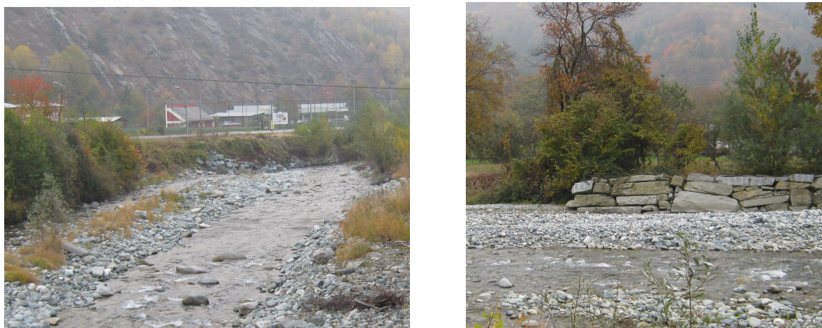
Figura 35 – Difese esistenti lungo la sponda sinistra e lungo la sponda destra in parte dissestate e prive di immorsamento
